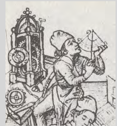
Mittelalterlicher Uhrmacher stellt seine mechanische Räderuhr mit einem Sonnenhöhenwinkelmesser nach der Sonne. 3
